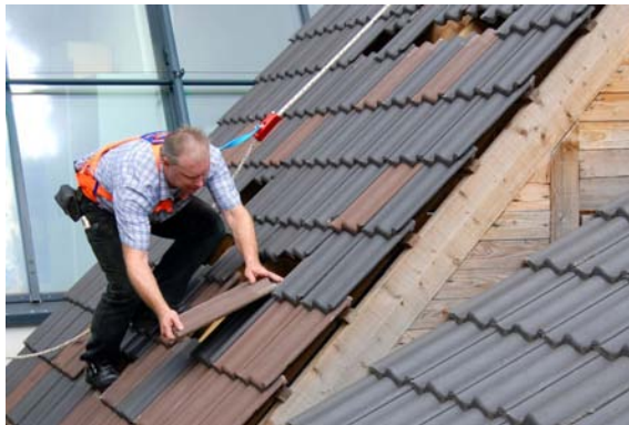
Dachdecker: Dach auf- und abdecken
