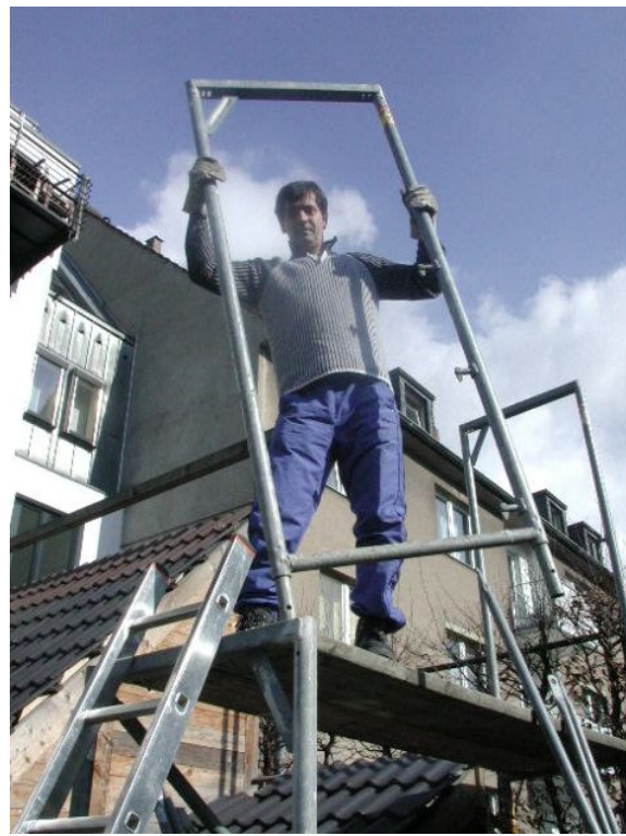
Gerüstbauer: Gerüst auf- und abbauen
