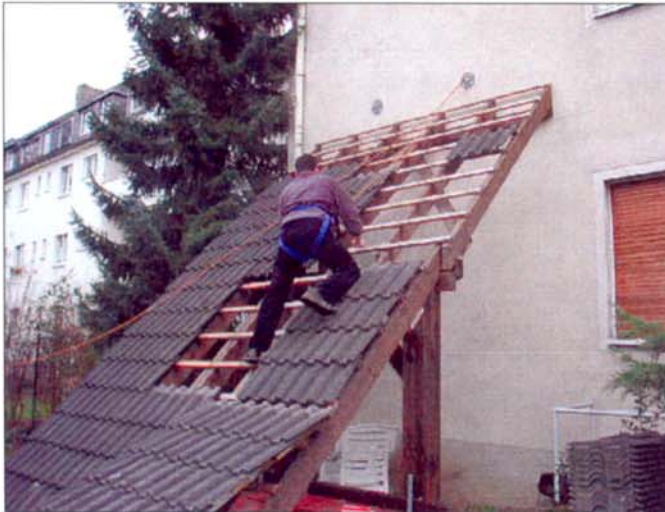
Dachdecker beim Eindecken
